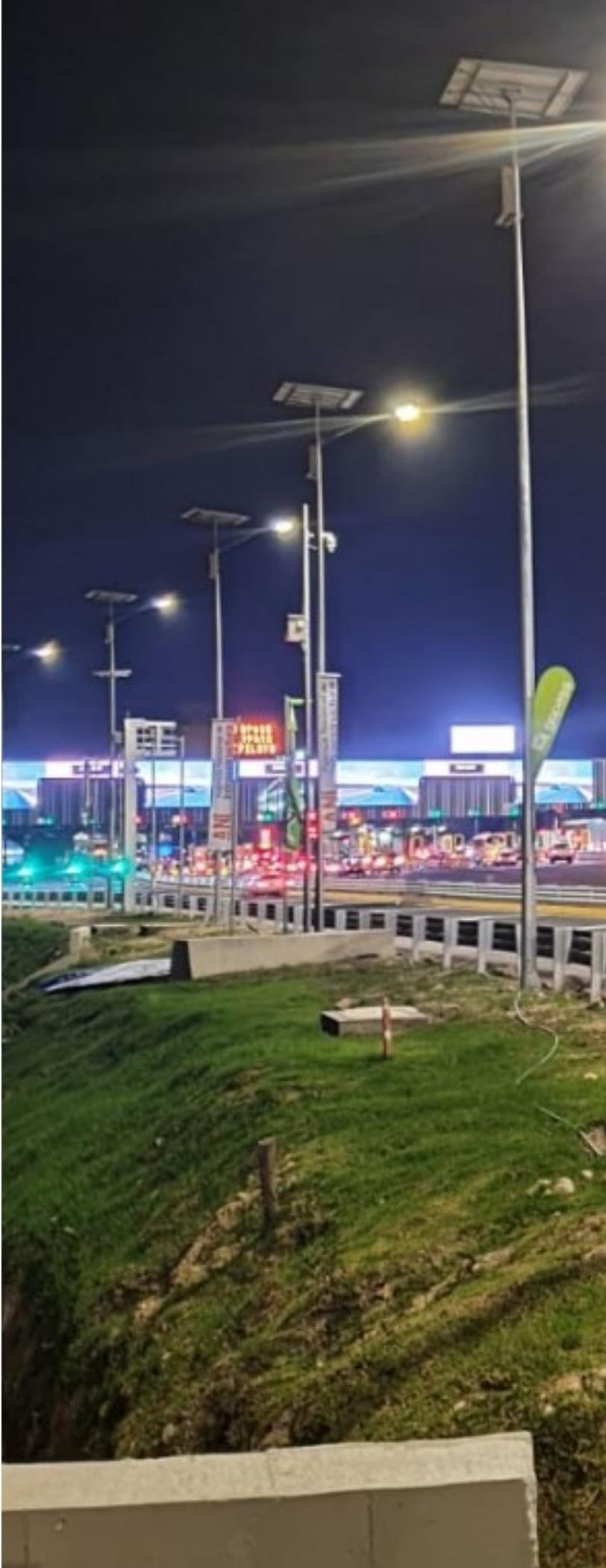
La luminaria LED solar está compuesta de panel solar, luz LED, batería de litio-ferrofosfato, controlador, driver de corriente constante y cuerpo de la luminaria. Se combina de múltiples tecnologías de control incluyendo efecto fotoeléctrico, control de corriente constante, microcontrolador, detector por infrarrojos. Ideal para utilizar en zonas sin red eléctrica o con problemas de suministro.
